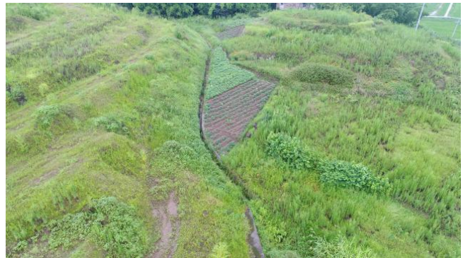
弃渣场排水沟
