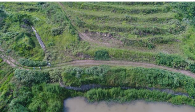
弃渣场挡渣墙
