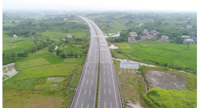
道路边坡防护及排水
