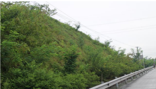
挖方边坡防护
